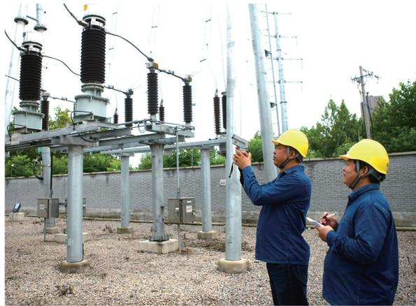
针对近期我县雷雨天气增多的情况,连日来,县供电公司运维人员利用雨停间隙,积极开展变电站设备特巡工作,确保供电安全。图为8月12日,该公司运维人员在110千伏恒河变电站,利用红外线测温仪进行变压器套管连接处、刀闸口、线夹接头等处测温并做好记录。
