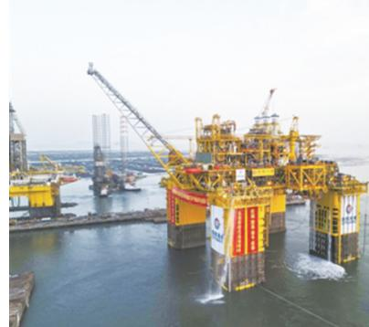
酯缆锚泊系统设计与安装、30年不进坞维修的浮体结构疲劳设计与检测等在内的13项国内首创技术，攻克了10多项业界难题。
