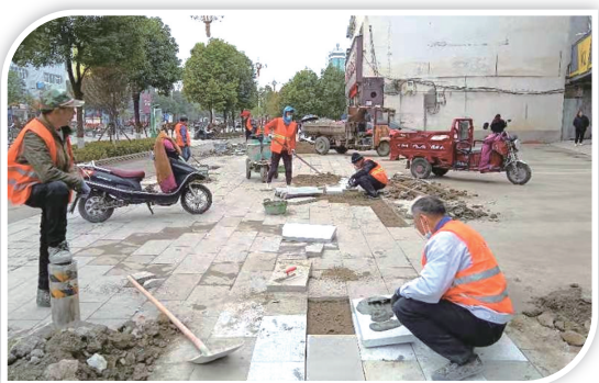
▲3月22日,县住建局对县城人民路中段的路面进行翻修铺砖。 杨跃峰 摄影报道
