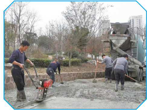
▲住建局组织人员整修文笔山森林公园门口路面
