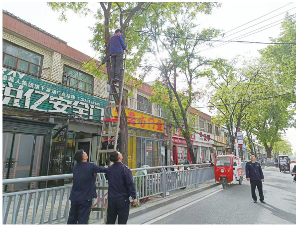
4月11日,县城市管理局组织施工人员在冯异路进行“三线”整治,助力文明城市创建。
