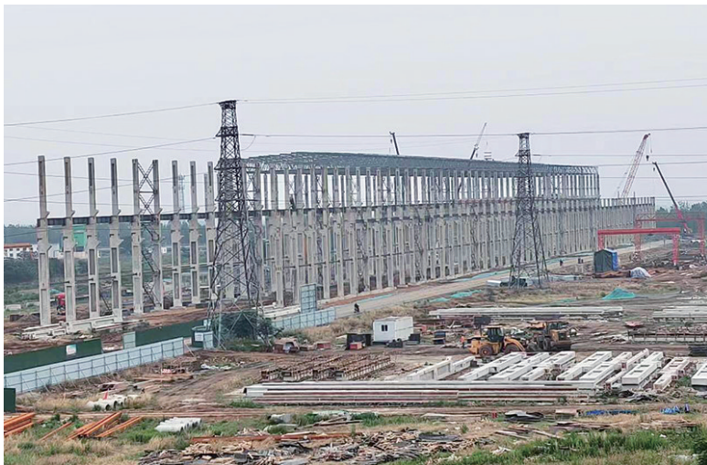
占地918亩的河南领创碳材料产业园项目建设现场
