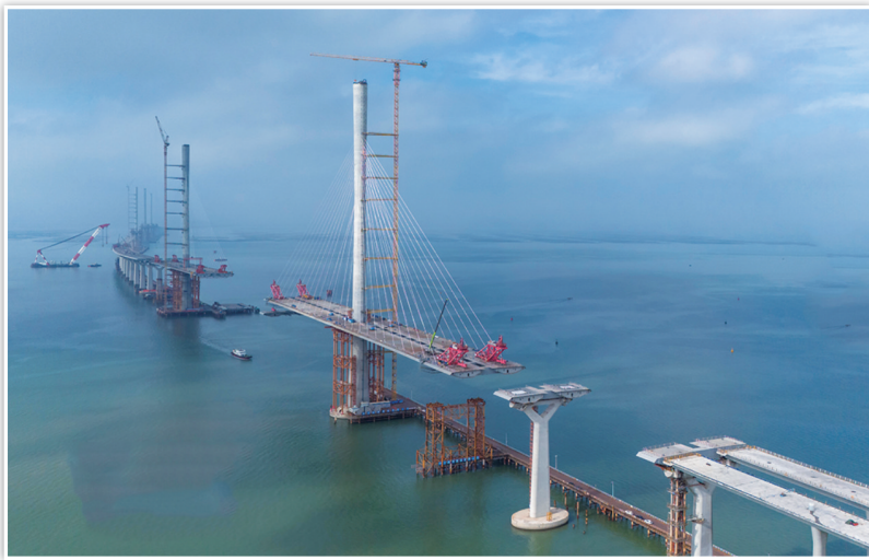
近日,广东省珠海市高栏港经济区黄茅海跨海通道高栏港大桥建设现场,建设工人正在加紧吊装钢箱梁。
