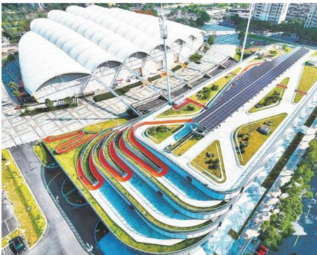
位于浙江省宁波市北仑区的立体停车场充电站,集屋顶公园、健身绿道、光伏发电等多功能于一体,实现了新能源汽车与电网双向充放电,达到“削峰填谷”的效果。
