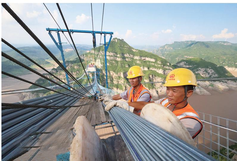
8月6日,济新高速公路黄河大桥建设现场,工人正在进行大桥主缆安装施工。济新高速公路黄河大桥是济(源)新(安)高速公路的控制性工程,大桥主跨555米,塔高109米,横跨黄河小浪底库区,是世界上首座地锚式回转缆索悬索桥,也是河南省在建的单跨跨度最大的桥梁。
