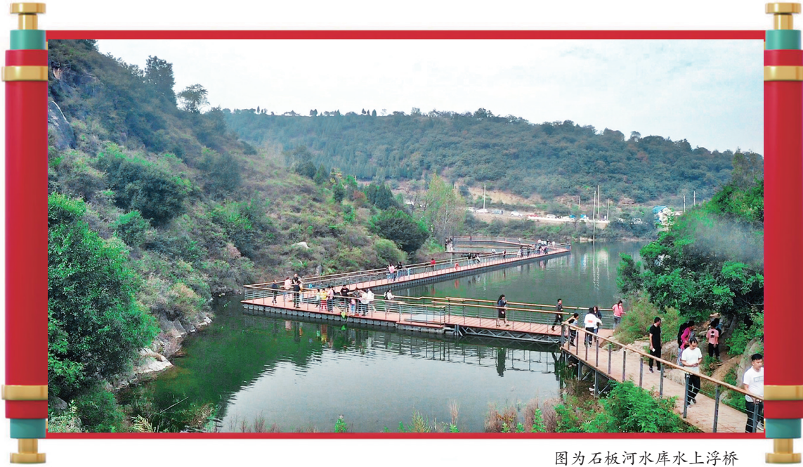
图为石板河水库水上浮桥
