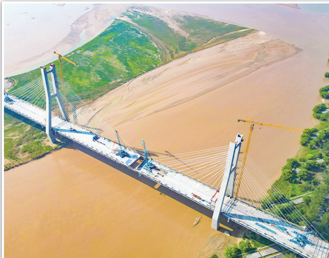
7月28日,河南境内兰原高速兰考至封丘段项目黄河特大桥主桥完成最后一根横梁吊装,提前一个月实现合龙,标志着项目建设取得决定性进展。 兰原高速兰考至封丘段项目建成后,将形成平行于连霍高速的东西向大动脉,对服务中部崛起战略、助推中原城市群发展、促进黄河流域高质量发展具有重要意义。 来源:人民网
